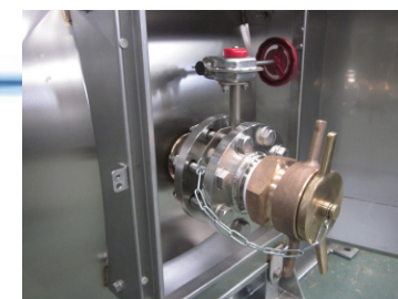
消防用ホースが取付易くなっています。 取付後のハンドルをひねると水が 放出されます。
