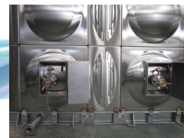
タンクには2つ接続口を設置
